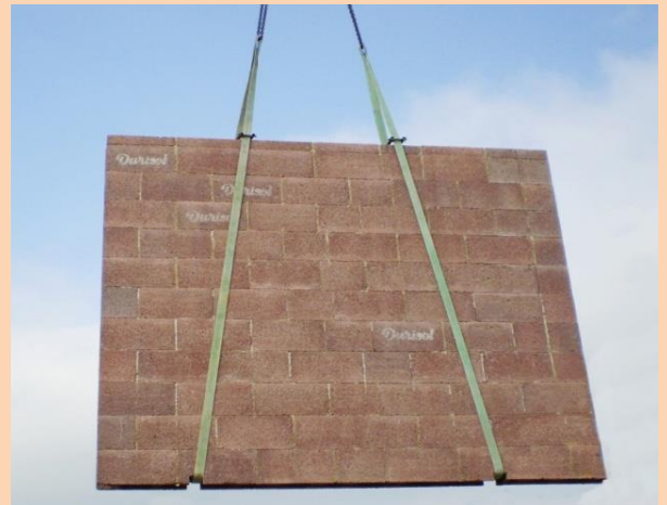
Durisol-Hohlwand maximale Größe 5,00 m x 3,00 m
